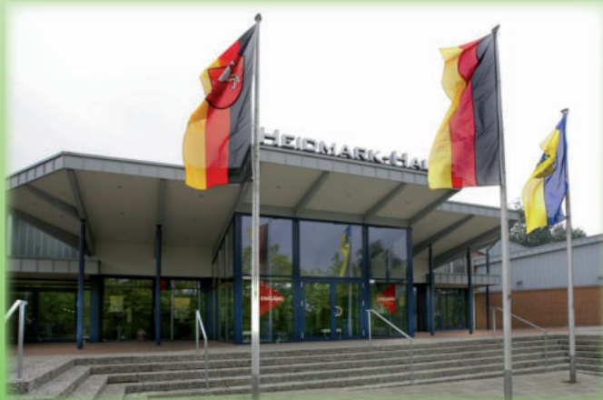
Heidmark-Halle Bad Fallingbostal
